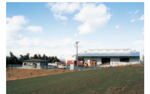
14 高根沢配送センター
